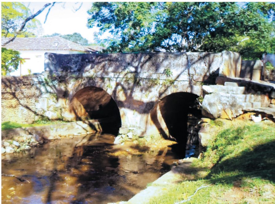
Figura 6. Puente de Piedra de Forras en doble arco. Tiradentes, M.G
