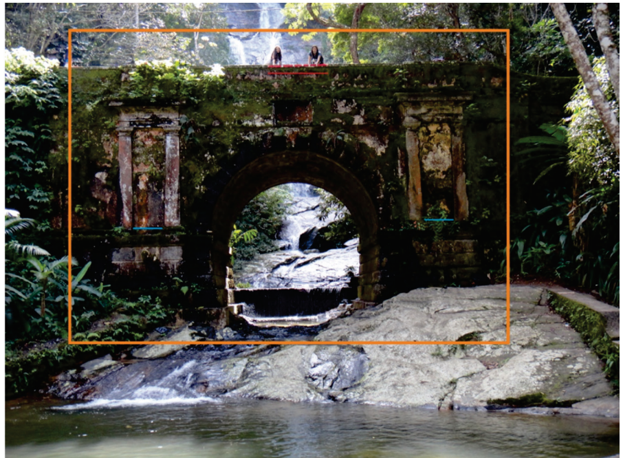
Figura 18. Se observan los líquenes y la vegetación parásita adheridas al puente.
